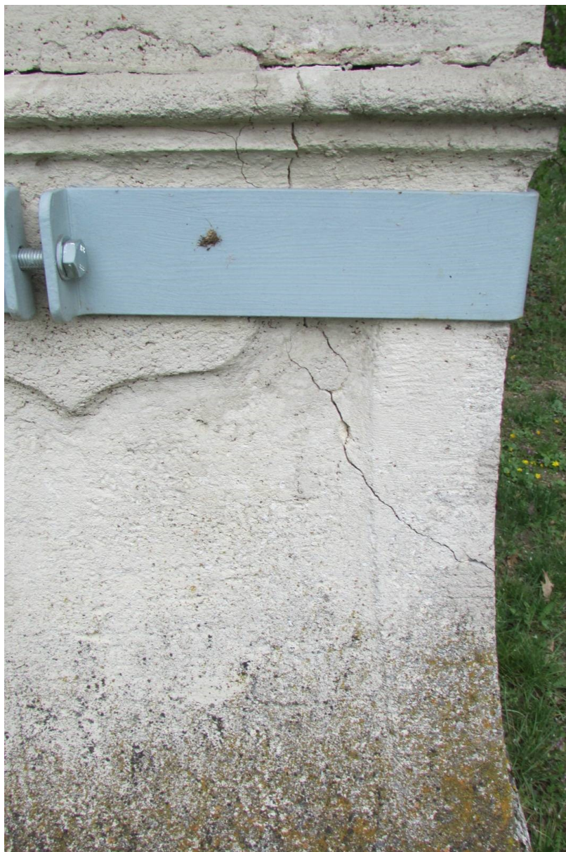
Detail provizorní sanace prasklin na podstavci
