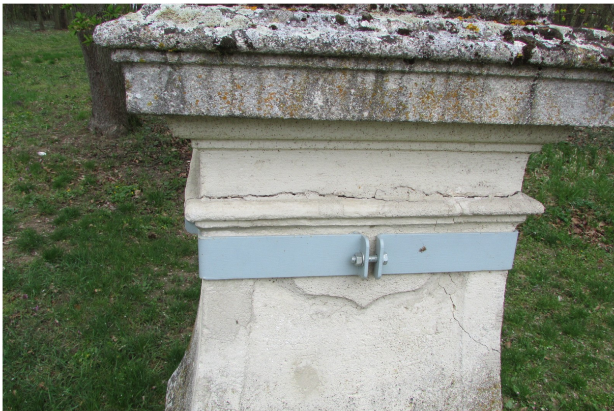
Detail provizorní sanace prasklin na podstavci
